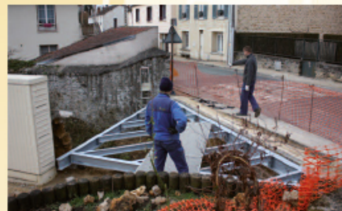
MARS • Les travaux Carrefour Jean Moulin se poursuivent : installation d'une passerelle piétonnière au dessus du ru de la Goutte d'or.
