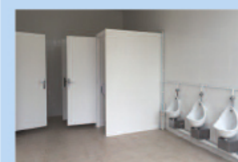
Remise à neuf des toilettes de l'école Jean Piaget
