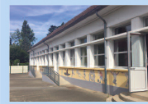
Réfection des façades de l'école Jacques Prévert
