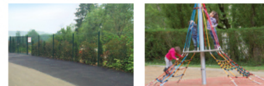
Clôture et habillage d'une aire de stockage à Talou
